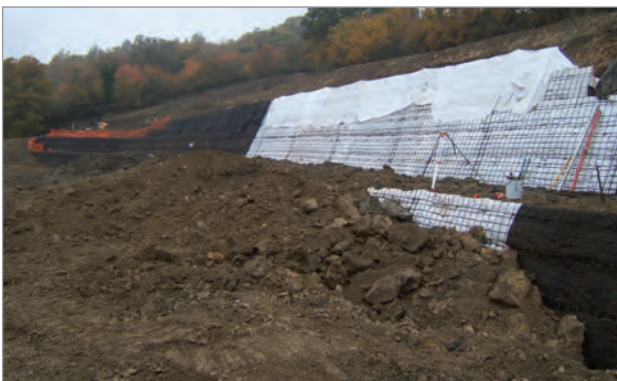
Posa Robutec dove verranno realizzate le tribune
