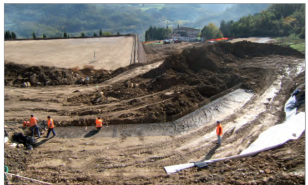
Posa del geocomposito Fildrain a tergo delle terre rinforzate
