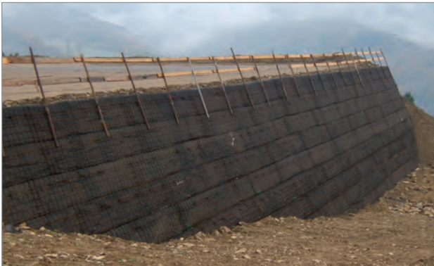
Fasi di realizzazione terra rinforzata a valle
