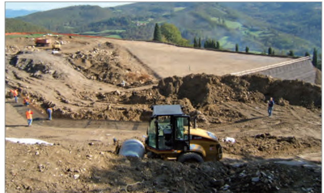
Fasi di realizzazione terre rinforzate a monte per tribune
