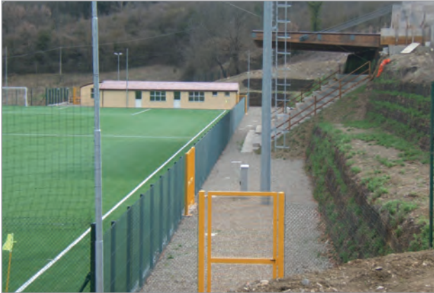
Terre rinforzate a monte del campo da calcio
