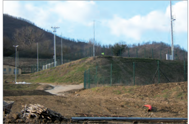
Terre rinforzate a valle del campo da calcio
